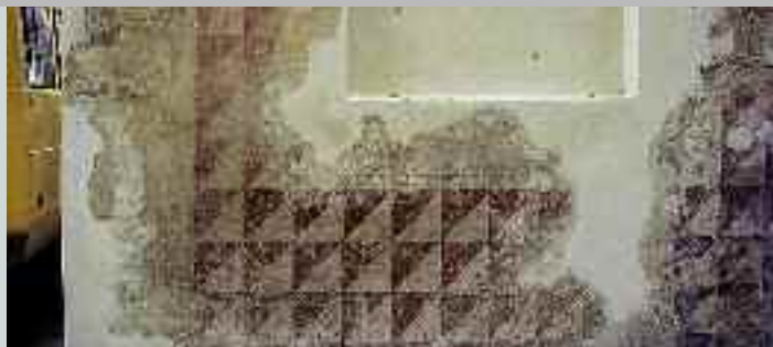
Ripristino eseguito a regola d'arte nel rispetto dell'esistente
