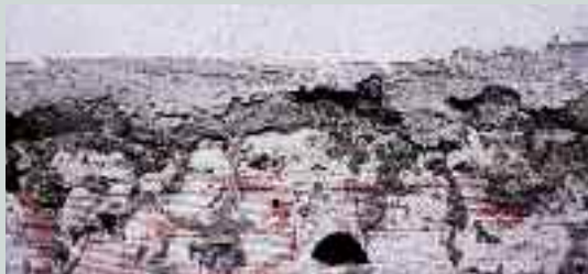
Muratura in mattoni forati e tre strati di intonaco
