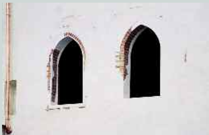
Ripristino eseguito a regola d'arte nel rispetto dell'esistente
