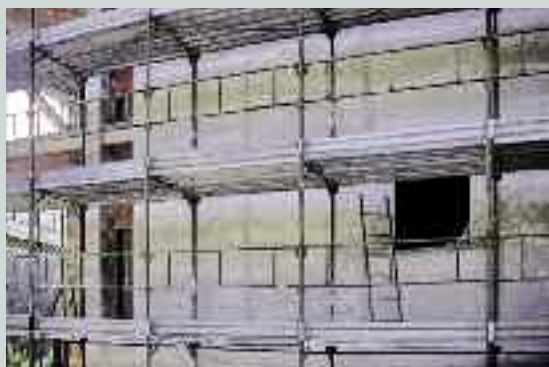
Esecuzione di intonaco premiscelato
