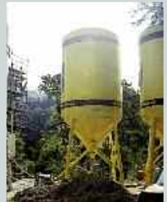
Silo e macchina intonacatrice
