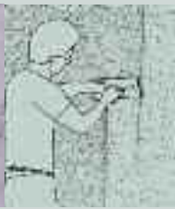
Posa dello strato di stabilitura o intonaco civile
