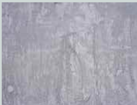
Particolare di intonaco di fondo premiscelato staggiato
