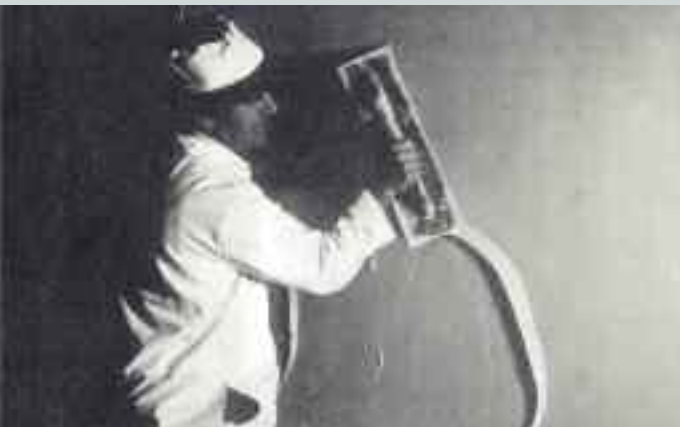
Fase di liscivia con spatola in acciaio
