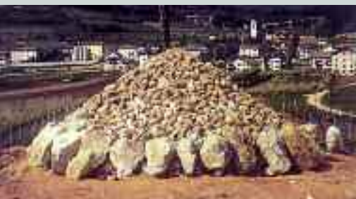
Ultimazione del riempimento con pietre calcaree disposte a volta, ricoperte poi con argilla e rami di pino
