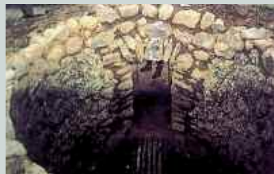
Muro di contenimento in porfido e argilla resistente a 1500 °C
