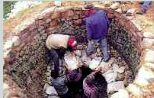
Riempimento del forno con pietre calcaree
