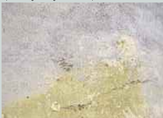
Ripristino di intonaco non conforme all'esistente
