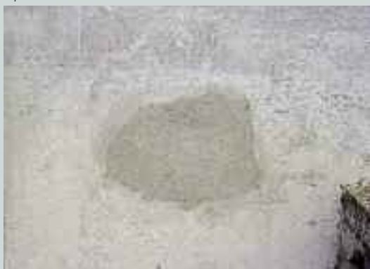
Ripristino di intonaco non conforme all'esistente
