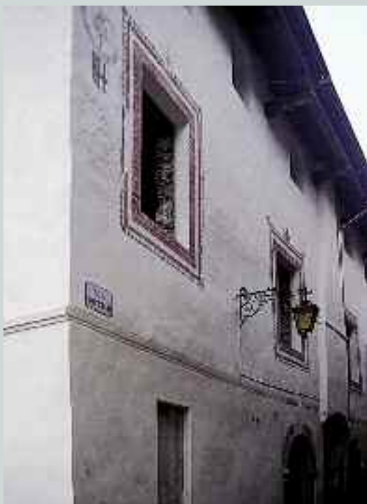
Ripristino eseguito a regola d'arte nel rispetto dell'esistente
