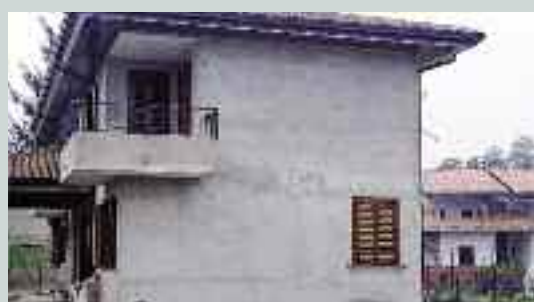
Intonaco rustico frattazzato
