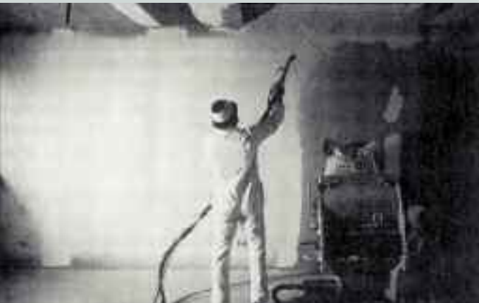
Fase di applicazione a spruzzo su di un soffitto
