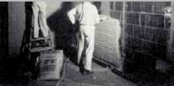
Fase di applicazione a spruzzo su di una parete di premiscelato a base di gesso
